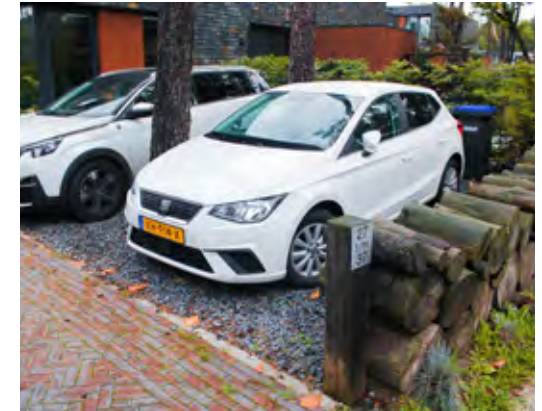
Een privéparkeerplaats voor twee auto's met halfverharding om verharding te beperken
