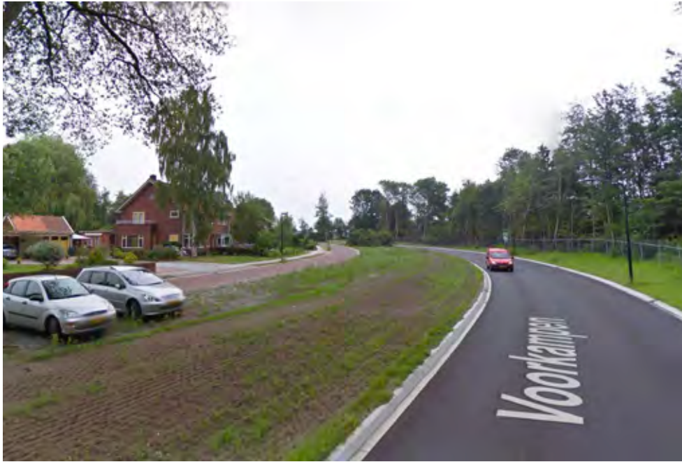
Minimaal ruimtebeslag van een rondweg. Voorkampen, Google Maps 2010, geen ontsluiting naar woningen vanaf rondweg Voorkampen waardoor de ventweg er parallel naast ligt
