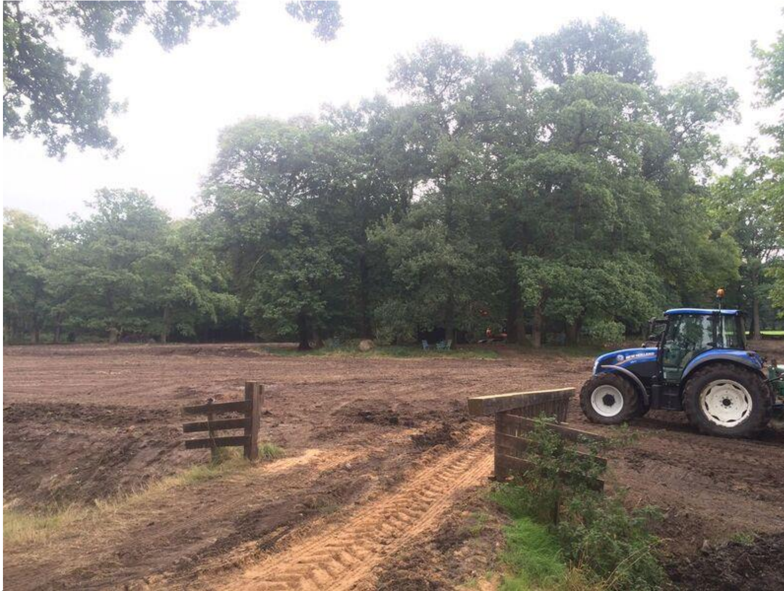
Afwerken depot voormalig hertenkamp de Braak
