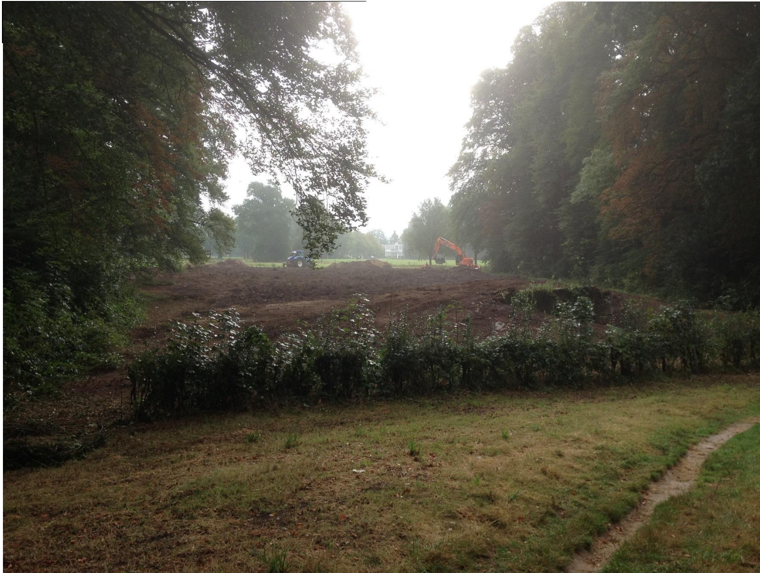
Afwerken baggerdepot zichtlijn vleermuiskelder de Braak
