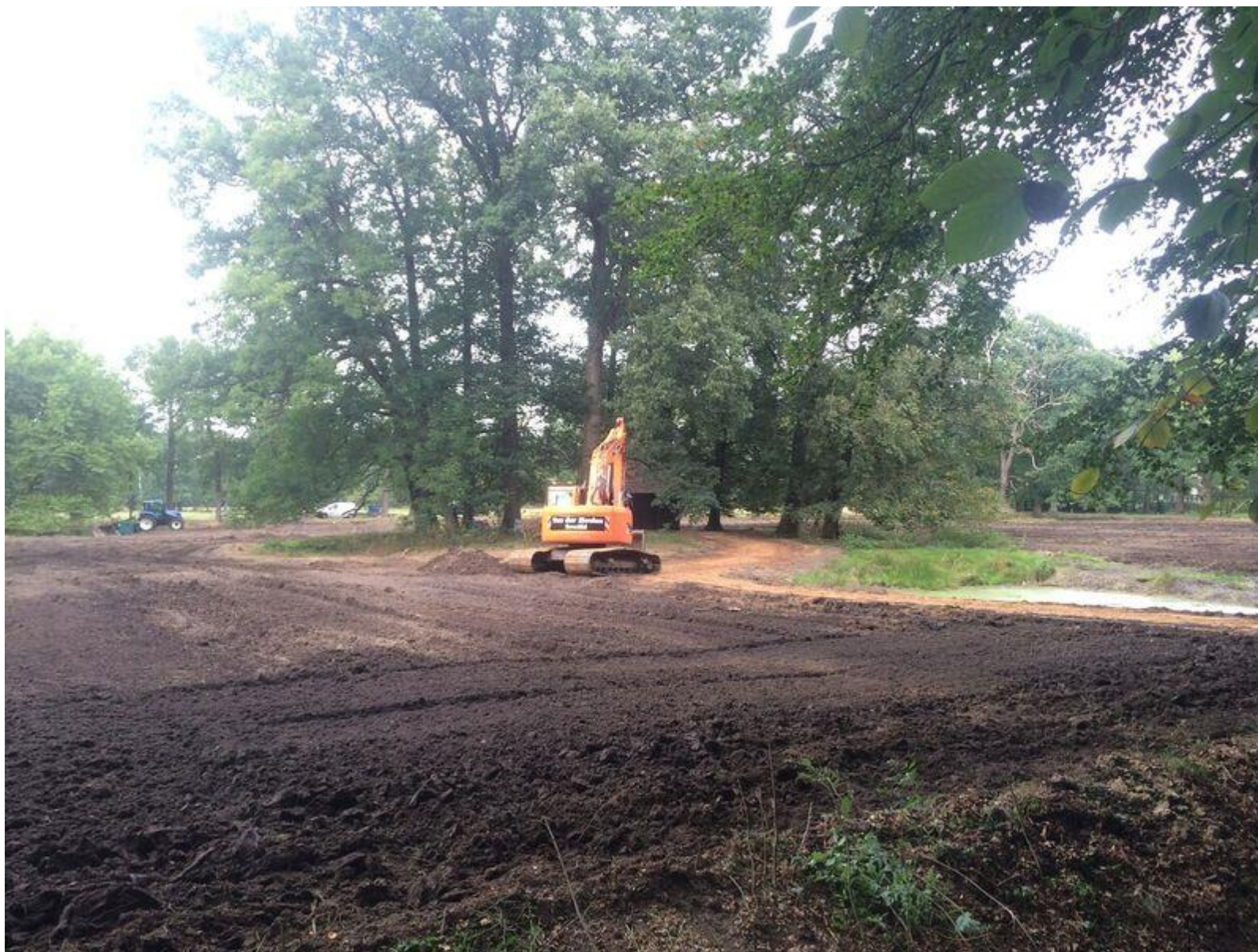
Aanleg nieuw pad naar voormalig hertenhuisje de Braak
