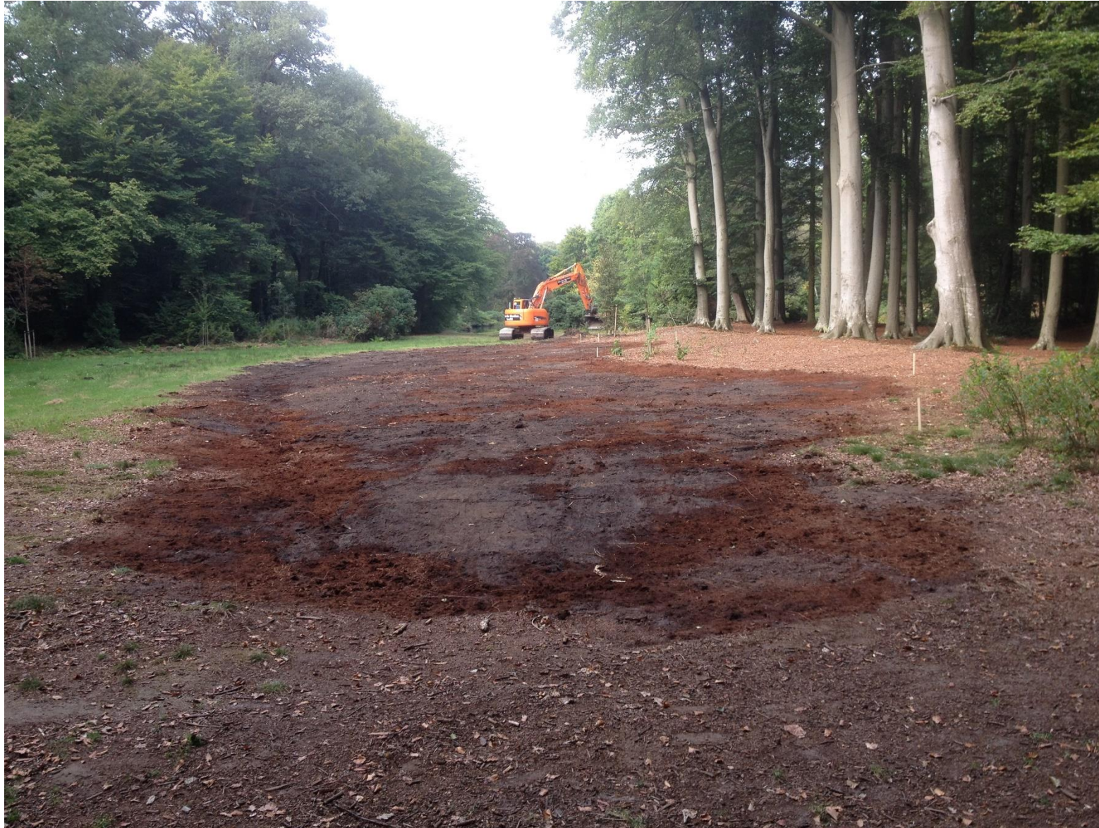
Verwijderen strooisellaag zichtas Vennerstraat
