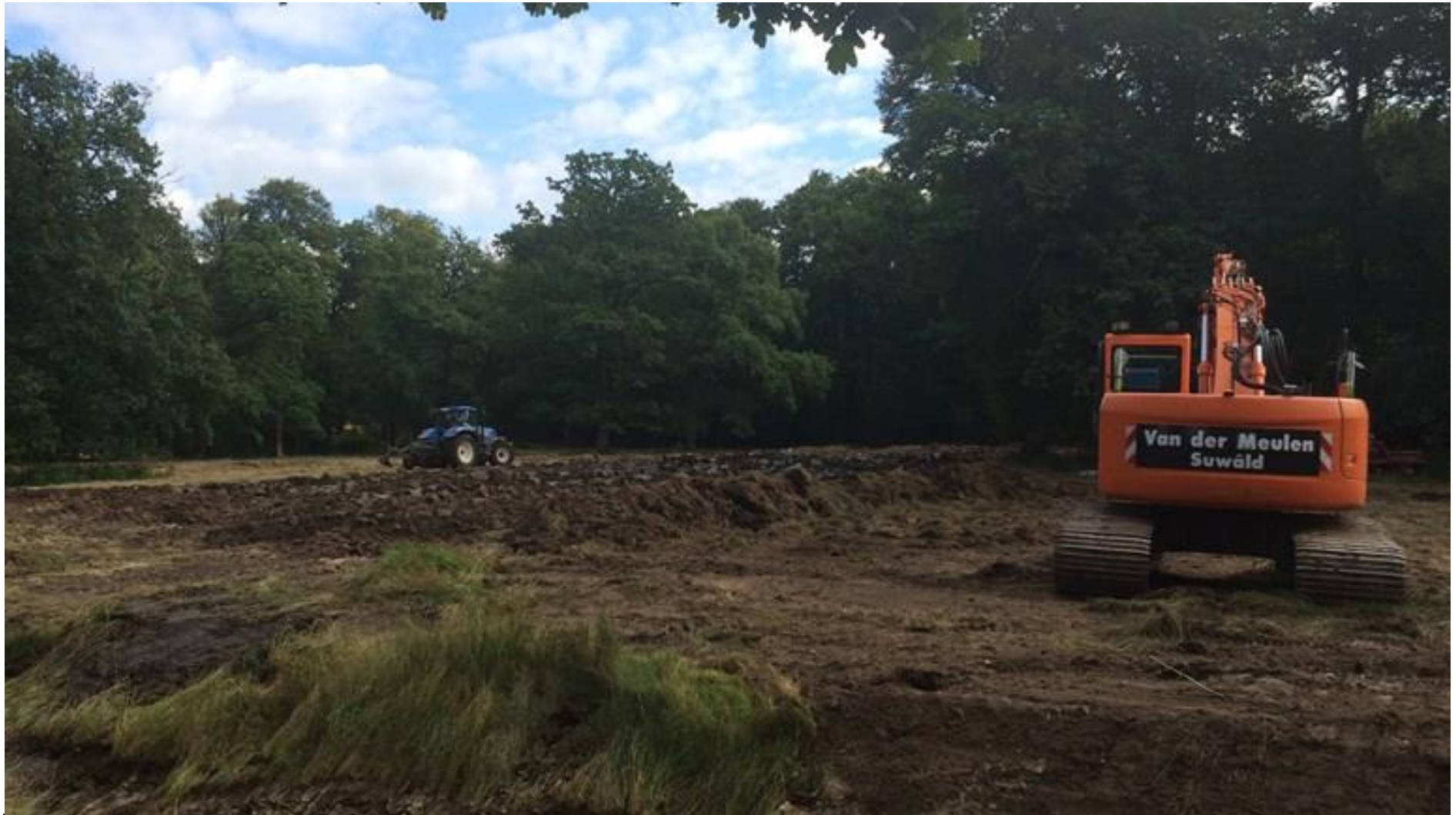
Herstellen baggerdepot voormalig hertenkamp
