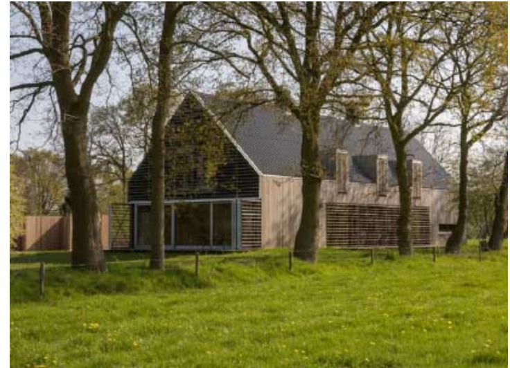
houten gevel, golfplaten dak, luiken, dakkapellen
