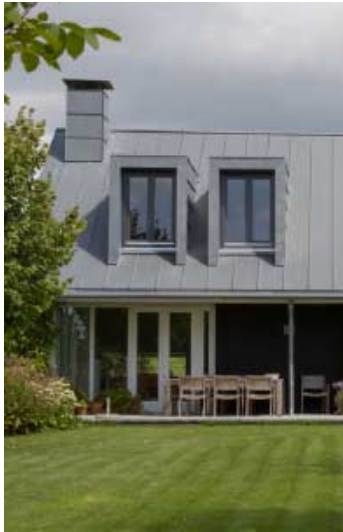
dak en dakkapel zink
