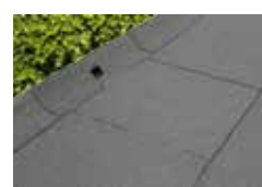
Platte daken (bitumen)
