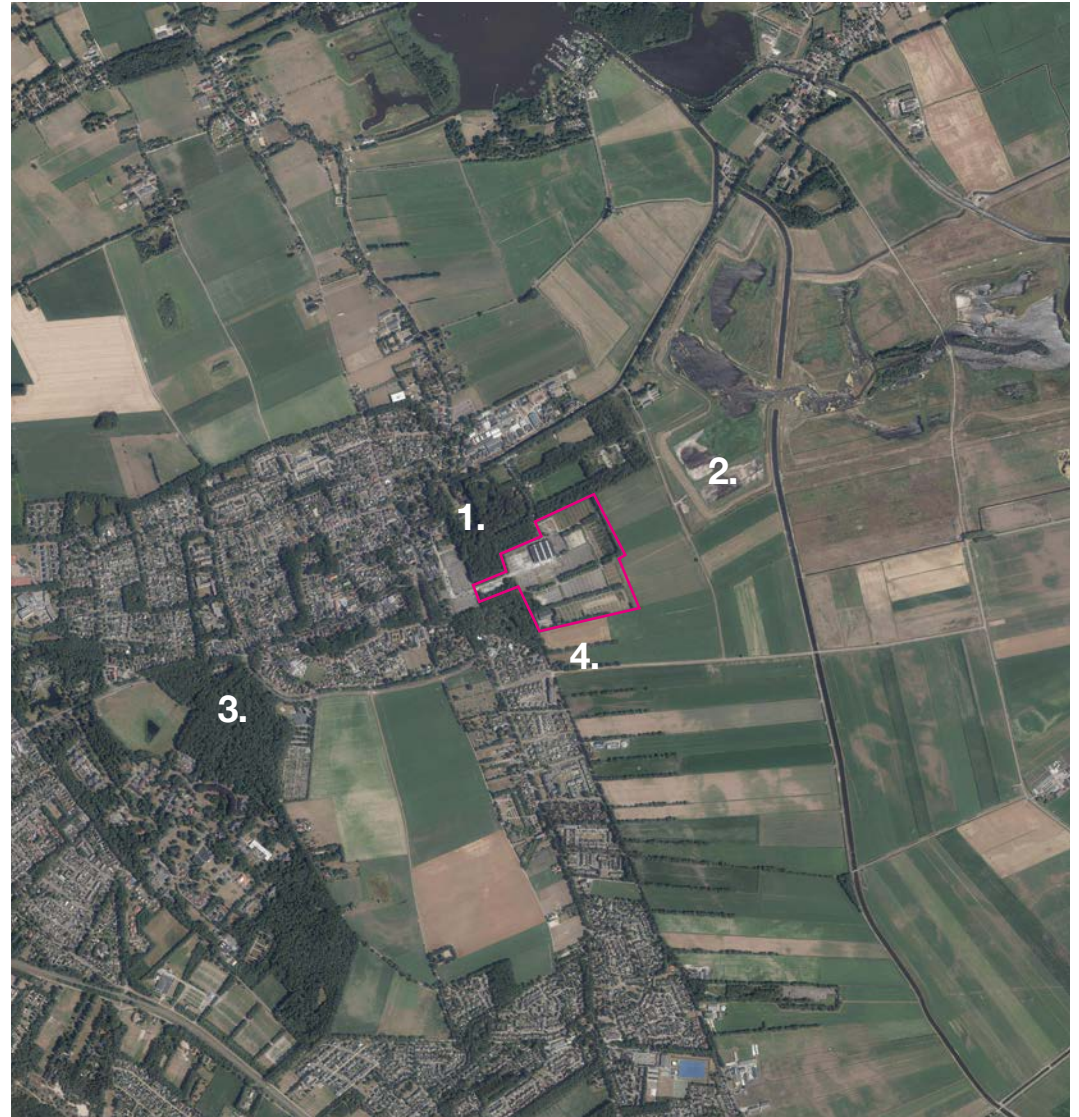
Luchtfoto achterzijde Laarhove
