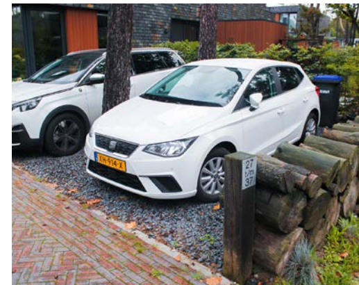
Een privéparkeerplaats voor twee auto's met halfverharding om verharding te beperken
