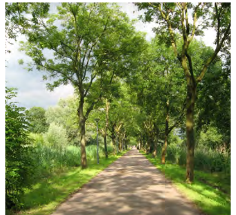
Hunze-as: asfalt Referentie: Kalfjesweg, Amsterdam
