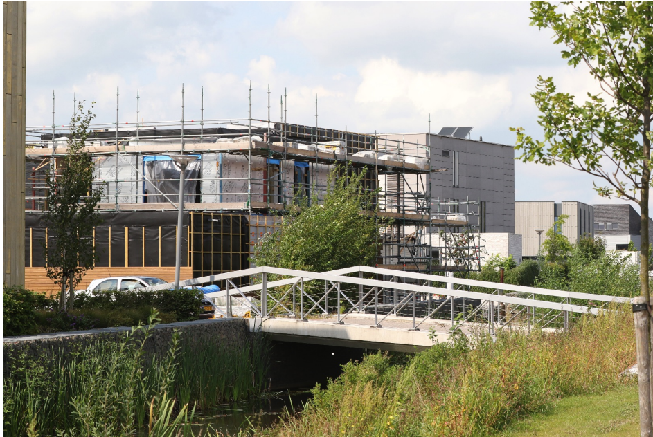
Woningen in aanbouw in Ter Borch
