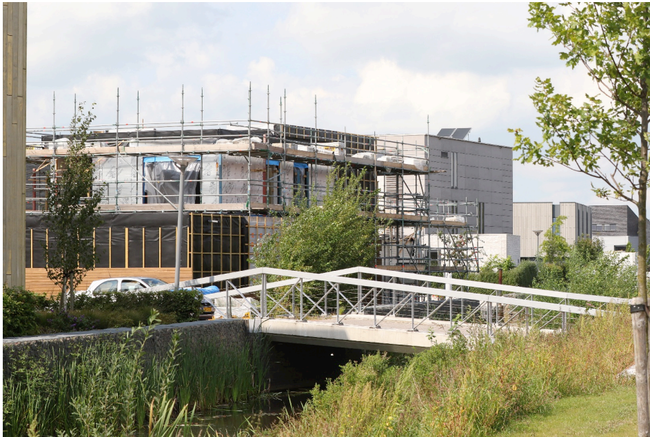
Woningen in aanbouw in Ter Borch
