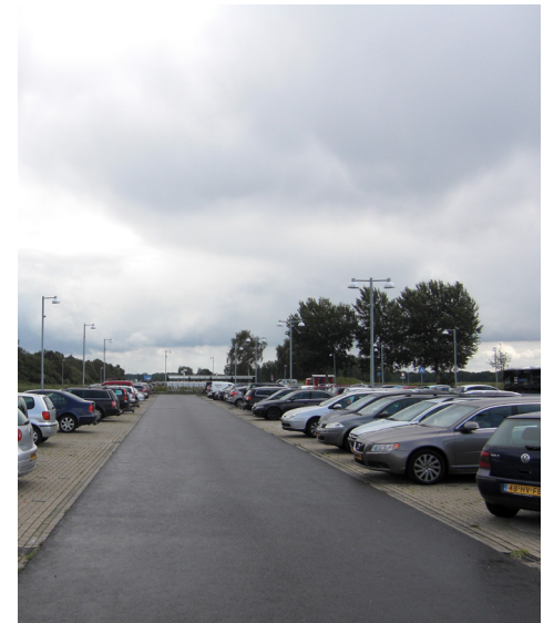
Bestaande P&R met asfalt en grijze betonsteen
