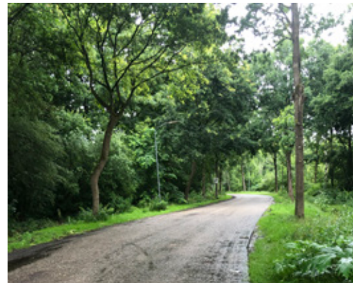
Toegangsweg Hanekamp, 6,5m. breed
