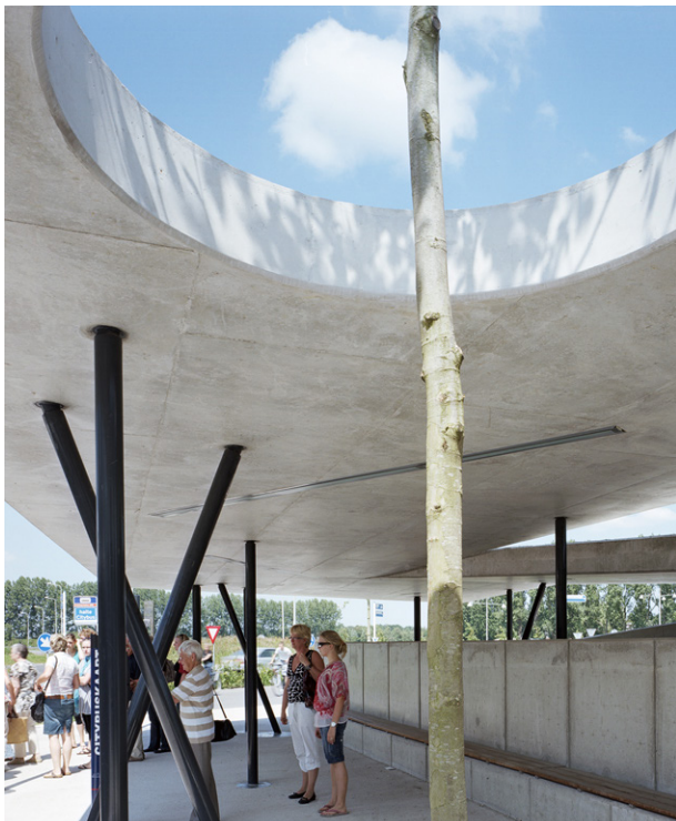
Referentie betonnenvloeren, transferium Haren, Onix
