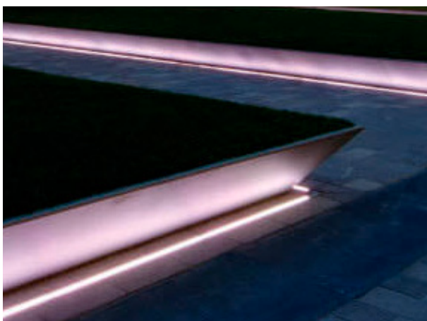
Het aanlichten begeleidende elementen langs de wandelpad.
