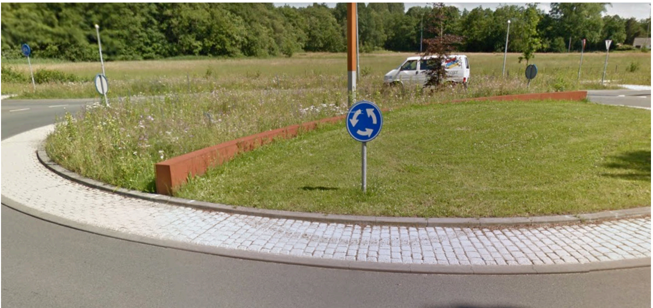
Voorbeeld van een groene, ecologische rotonde; rotonde Hoofdweg - Meerweg in Paterswolde
