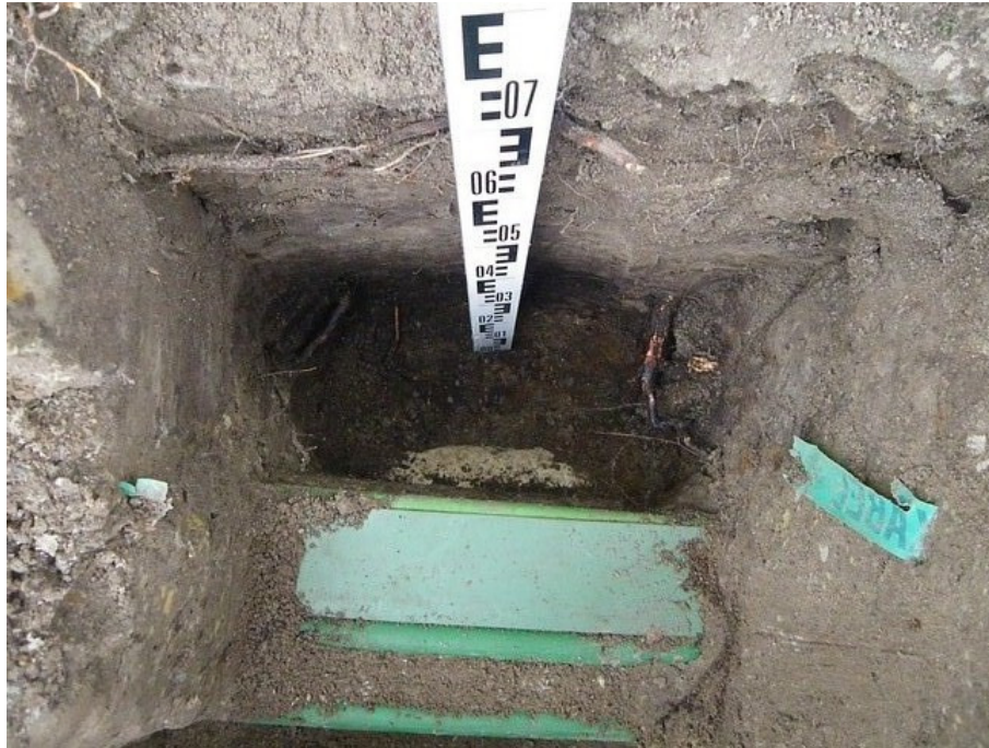
Foto 10: Kabels en leidingen bij gewone beuk onder trottoir
