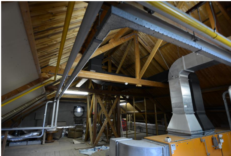
De zolderverdieping: spanten, dakruiterconstructie en kap.
