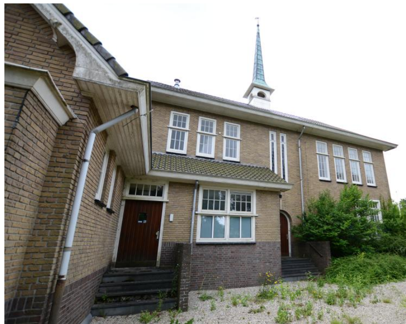
Overzicht noordelijke zijgevel met links de garage.
