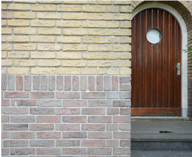
Metselwerk in gele en paarse Limburger steen.
