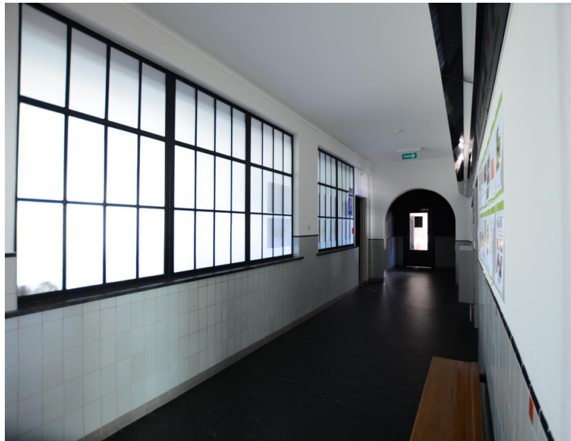
De hal in de zijvleugel, begane grond.
