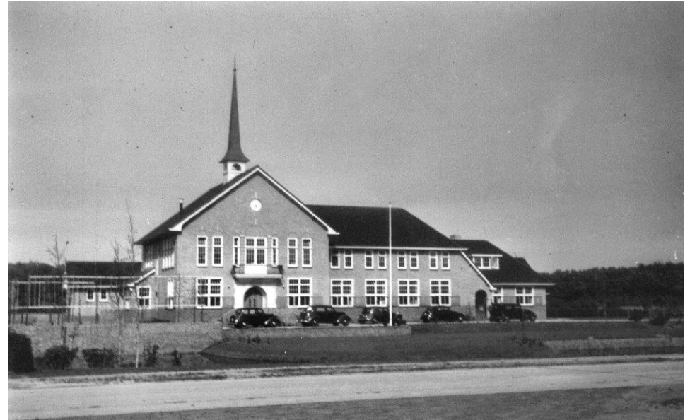
Het gemeentehuis van de voormalige gemeente Eelde aan de Prinses Irenelaan 1a te Paterswolde, 1958. Bron: Monumentenzorg:MZ Eelde, MZ10906000205, 11-03-1958.
